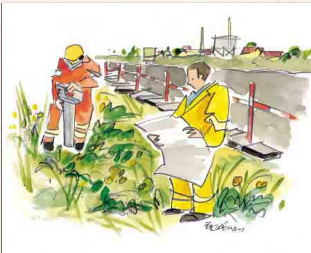
Påvisning af kabler
